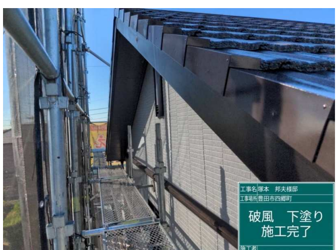
18 破風板 下塗り 施工完了
