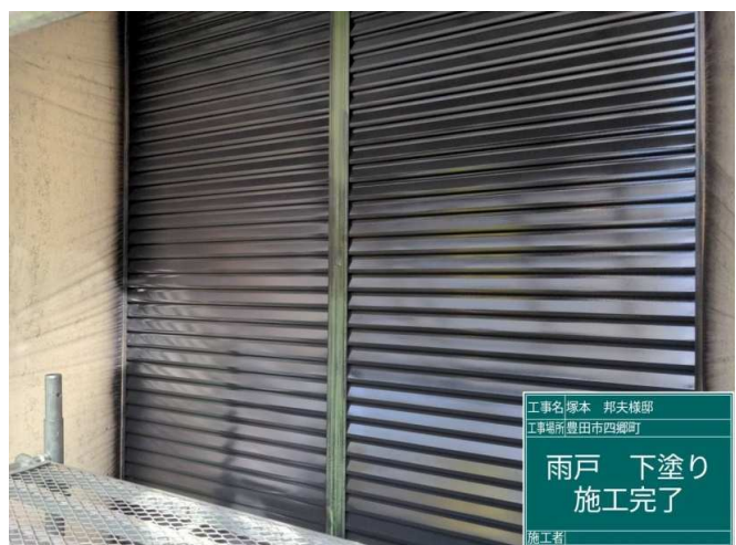
34 雨戸 下塗り 施工完了
