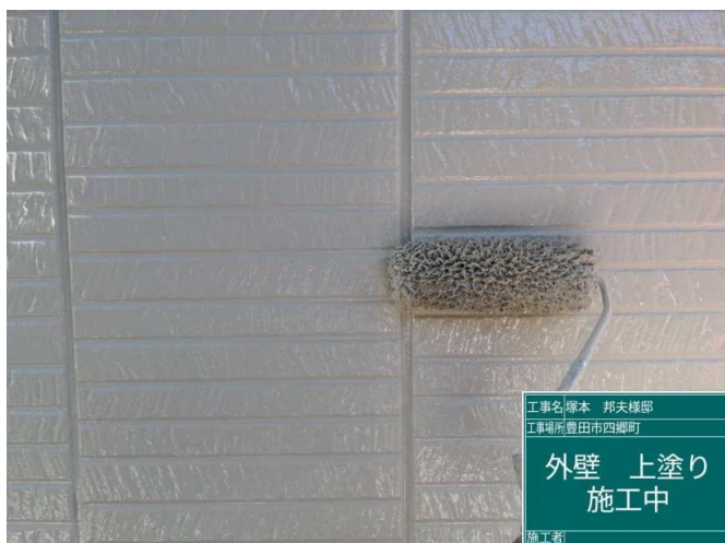
15 外壁 上塗り 施工中
