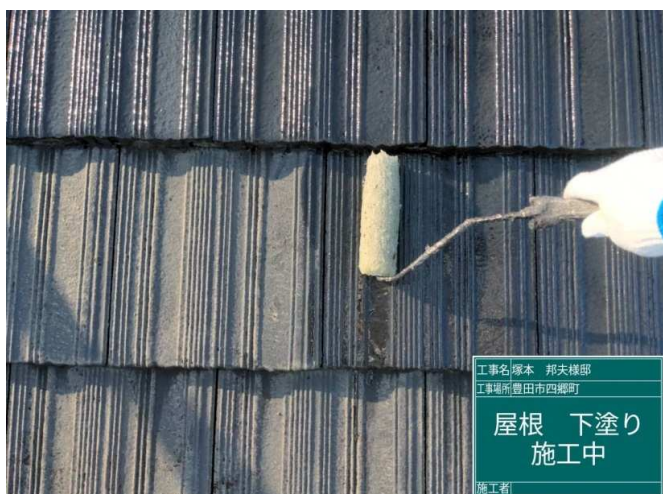
53 屋根 下塗り 施工中
