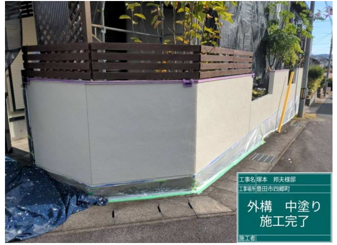
40 塀 中塗り 施工完了
