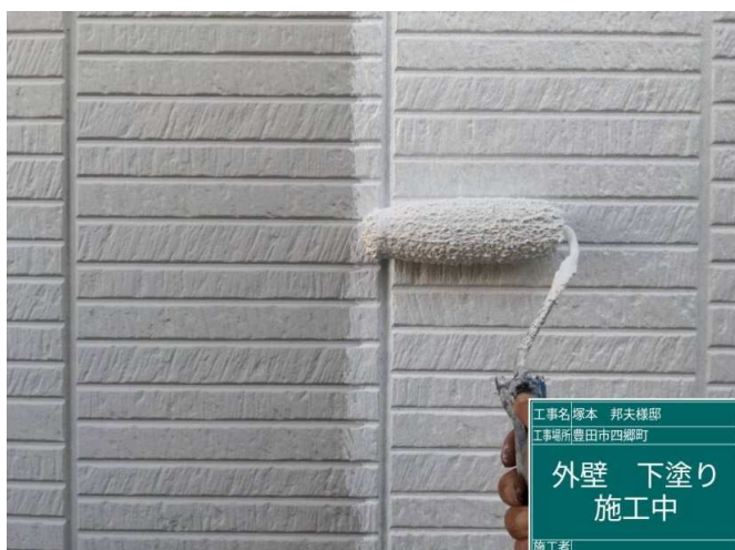
11 外壁 下塗り 施工中
