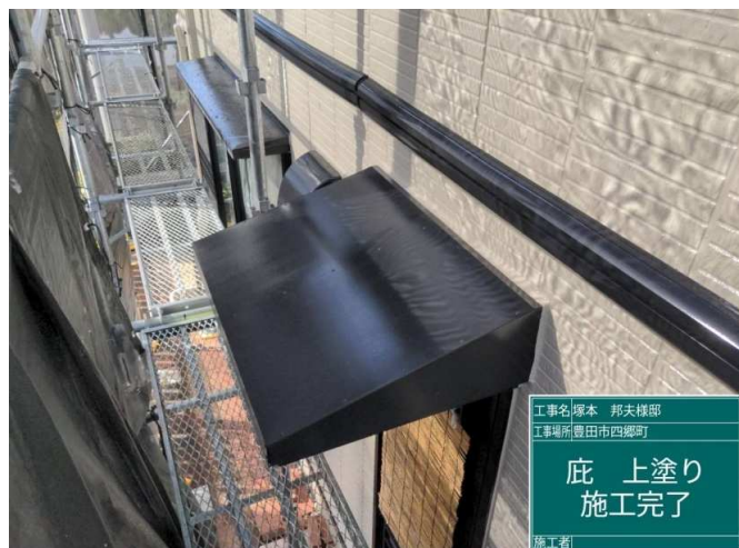
32 底 上塗り 施工完了
