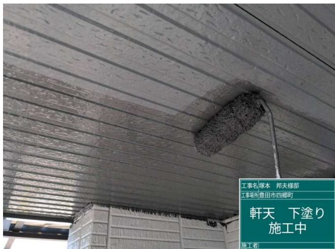
7 軒天 下塗り 施工中
