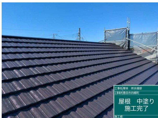
56 屋根 中塗り 施工完了
