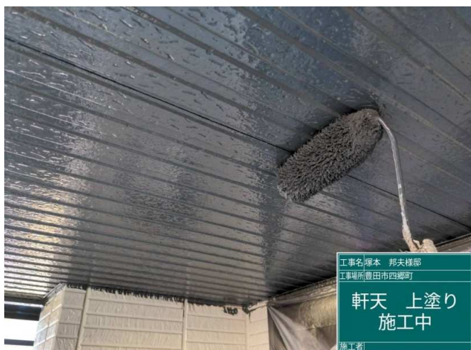
9 軒天 上塗り 施工中
