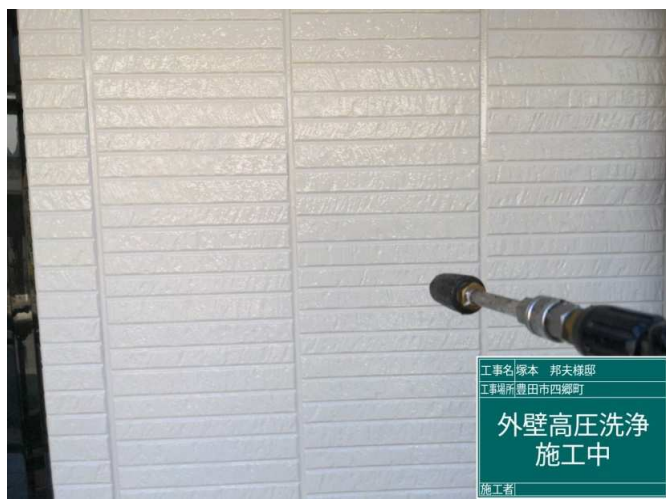
2 外壁高圧洗浄 施工中
