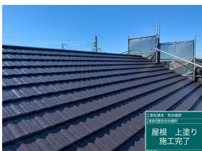
58 屋根 上塗り 施工完了
