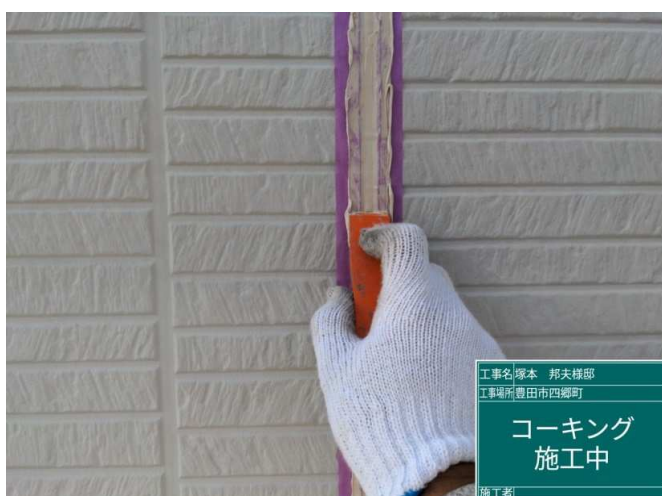
5 コーキング 施工中
