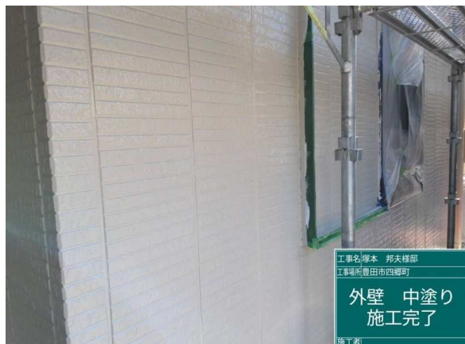
14 外壁 中塗り 施工完了
