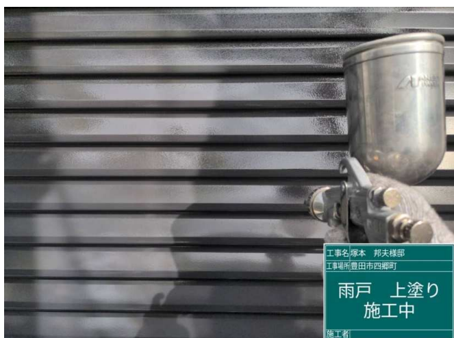
35 雨戸 上塗り 施工中
