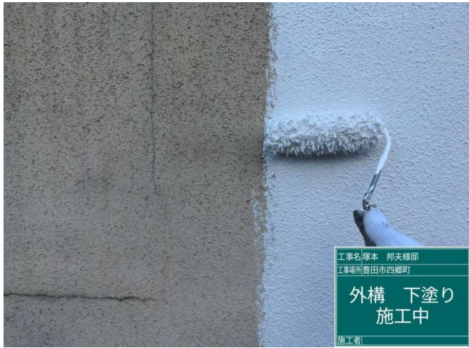
37 塀 下塗り 施工中
