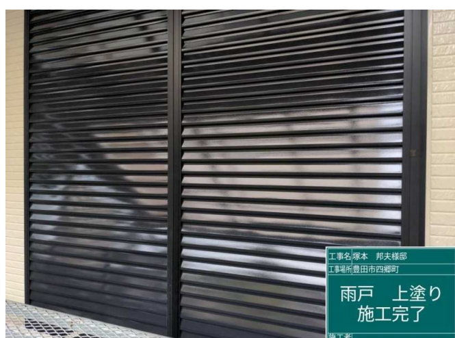
36 雨戸 上塗り 施工完了
