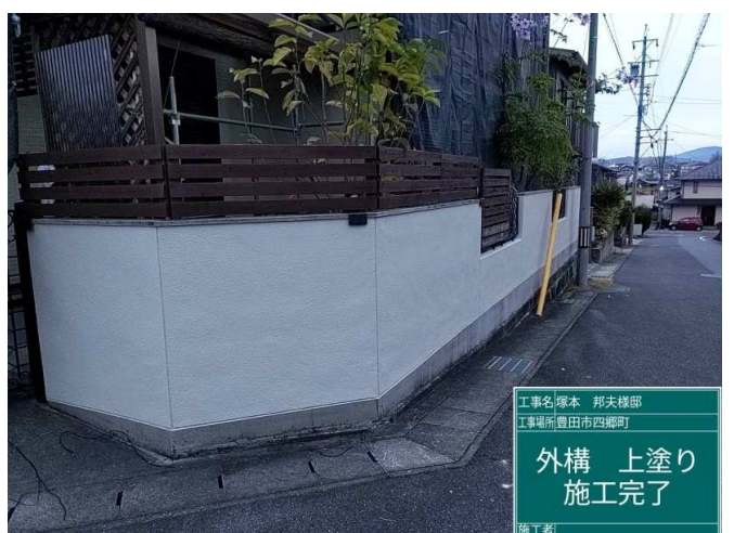
42 塀 上塗り 施工完了
