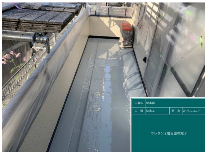
50 ベランダ ウレタン2増目 施工完了
