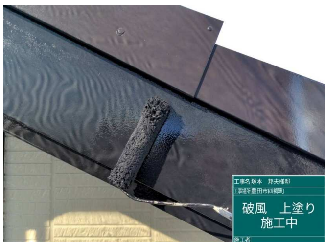
21 破風板 上塗り 施工中
