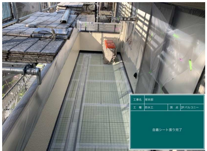
46 ベランダ 自着シート貼り 施工完了
