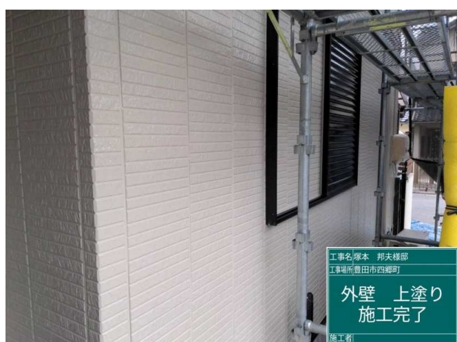
16 外壁 上塗り 施工完了
