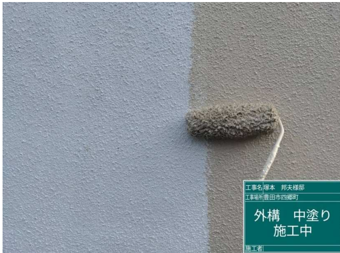
39 塀 中塗り 施工中
