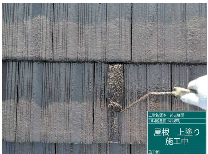
57 屋根 上塗り 施工中
