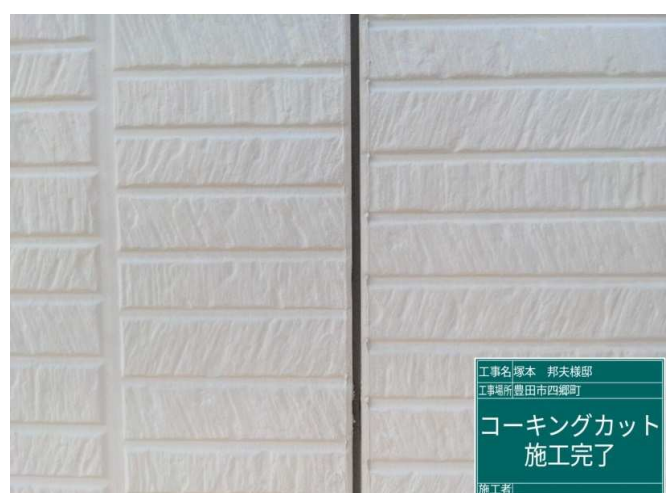
4 既設コーキングカット 施工完了
