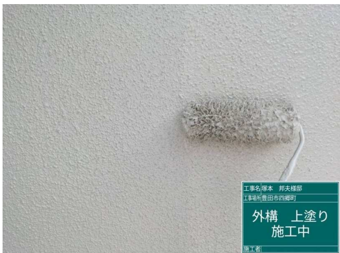
41 塀 上塗り 施工中
