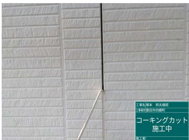
3 既設コーキングカット 施工中
