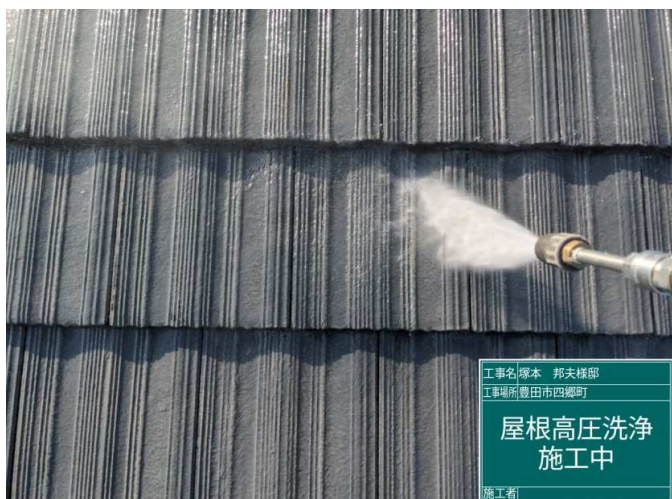
1 屋根高圧洗浄 施工中
