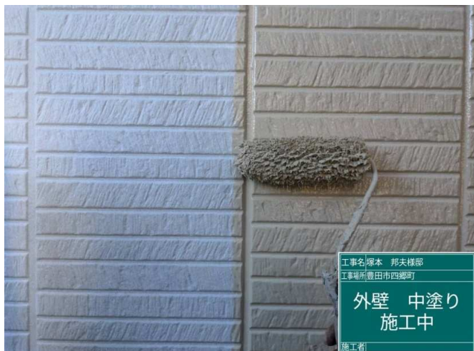
13 外壁 中塗り 施工中
