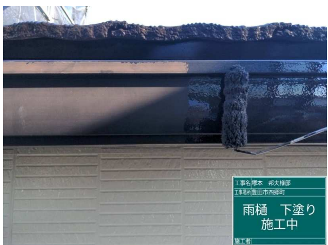
23 雨樋 下塗り 施工中
