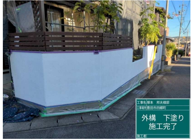
38 塀 下塗り 施工完了
