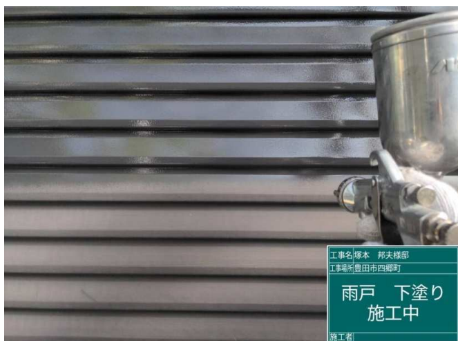
33 雨戸 下塗り 施工中
