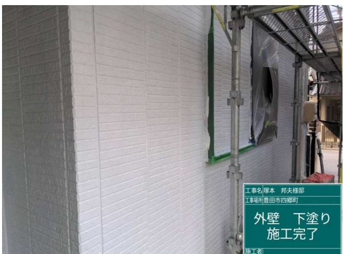
12 外壁 下塗り 施工完了
