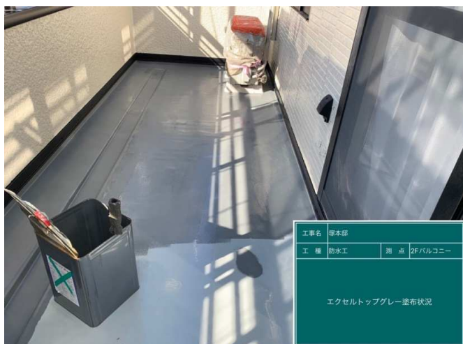
51 ベランダ トップコート 施工中
