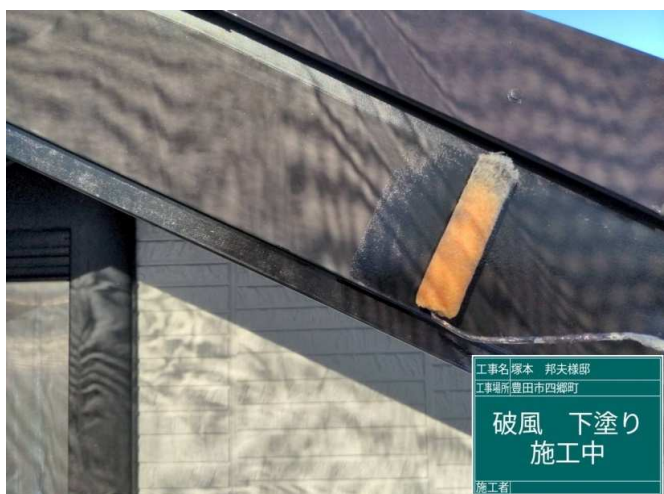
17 破風板 下塗り 施工中
