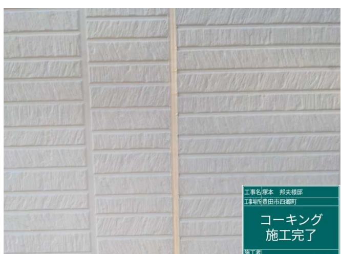
6 コーキング 施工完了
