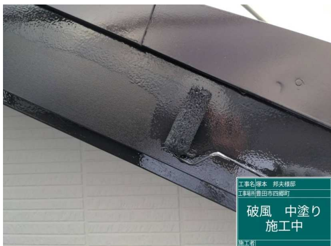
19 破風板 中塗り 施工中
