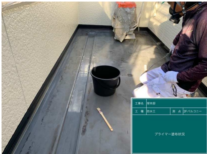
43 ベランダ 下塗り 施工中
