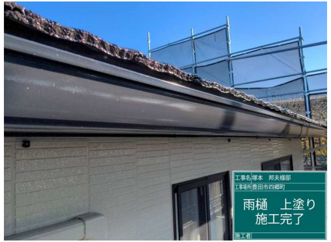
26 雨樋 上塗り 施工完了
