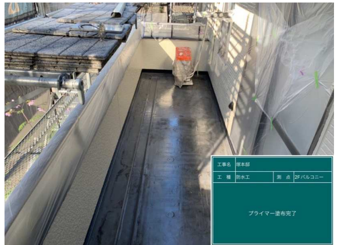
44 ベランダ 下塗り 施工完了
