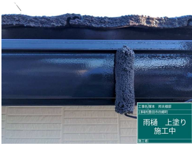
25 雨樋 上塗り 施工中
