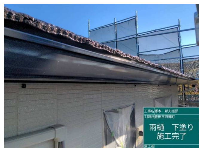
24 雨樋 下塗り 施工完了
