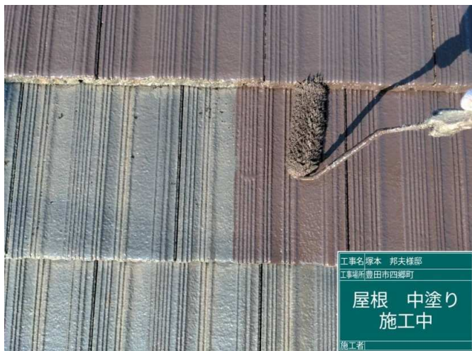
55 屋根 中塗り 施工中
